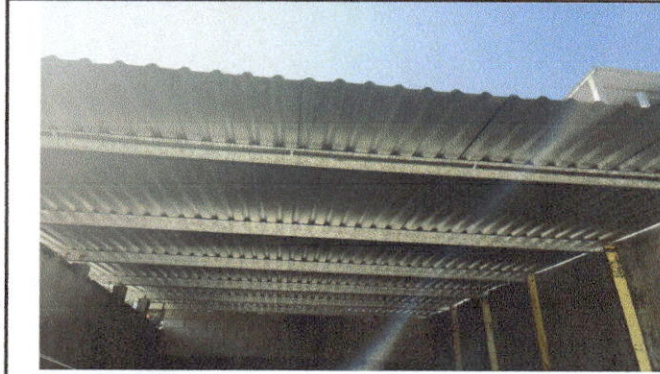
Foto 1: Sustrucción de lámina acanalada por lámina troquelada aluzinc calibre 26 y sustrucción de estructura de soporte de madera, por metal en módulo 1 de aula.
