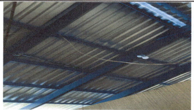
Foto 2: Mantenimiento de la estructura de soporte de madera (pintura) en módulo de baños.
