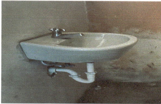
Foto 7: Sustitución de lavamanos en módulo 1 de aula.
