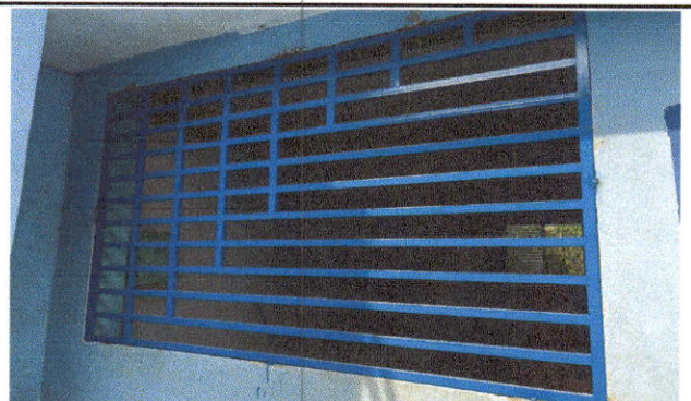
Foto 10: Sustitución de balcones de hierro en ventana en módulos 1 y 2 de aulas.
