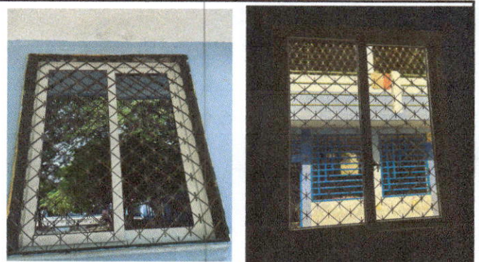
Foto 4: Sustrucción de ventanas de aluminio y vidrio de paletas por estructura de pvc y vidrio corredizo en módulo de dirección.
