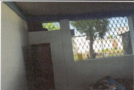
Foto 9: Sustitución de alisado de muro en módulos 1 y 2 de aulas.
